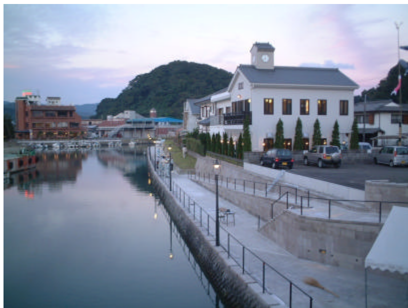
堀川運河整備状況
